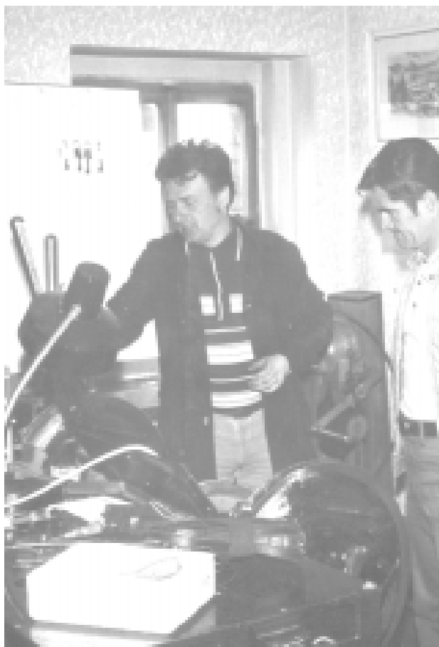
Obr. 27 Pracovníci SZD Plzeň provádí rekonstrukce ústředního stavědla Žichovice
