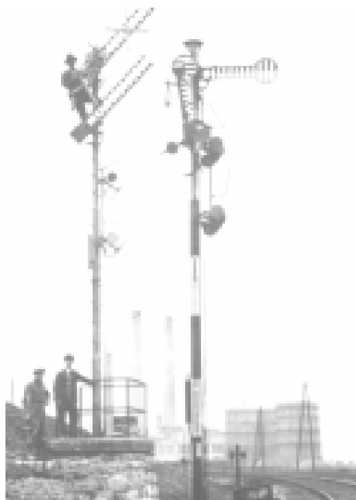
Obr. 4 Pracovníci SZD Cheb vyměňují návěstidlo DR (vpravo) za ČSD
