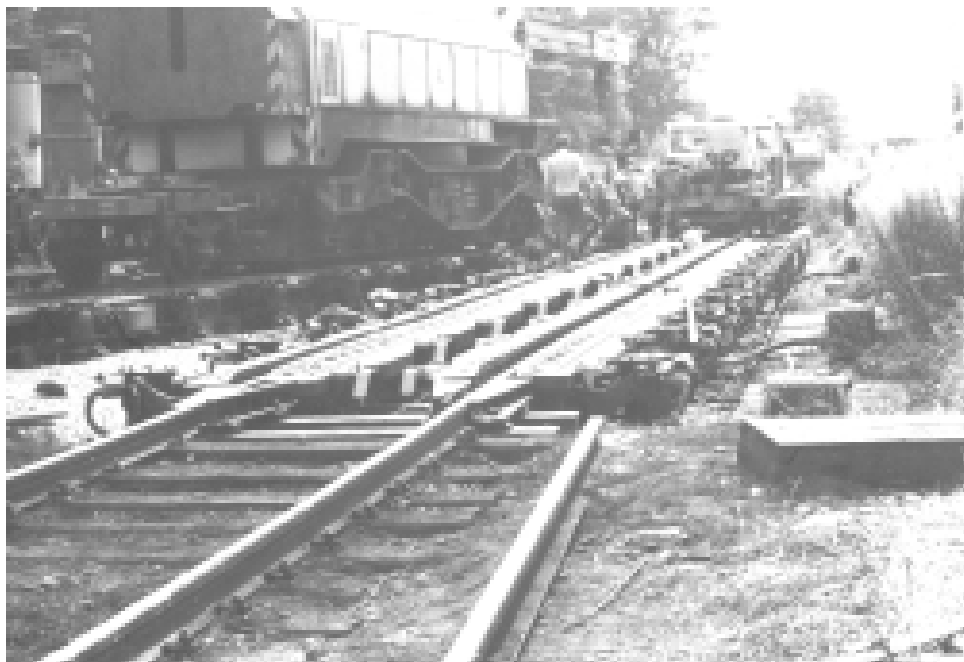
Obr. 32 Výměna kolejových brzd na spádovišti České Budějovice
