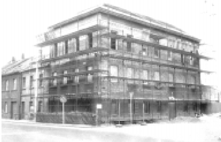
Obr. 24 Rekonstrukce objektu SZD Wenzigova 13
