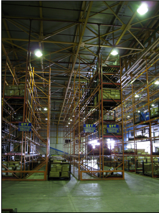
Σχήμα 5.10 & 5.11 Σύστημα αποθήκευσης στενών διαδρόμων με ράφια μεγάλου ύψους (VNA) στην αποθήκη της Ο.Α. - Υπηρεσίες
