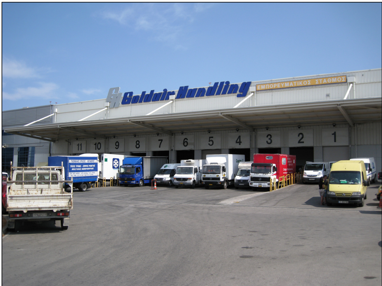
Σχήμα 5.6 Εξωτερική όψη (landside) του cargo terminal της Goldair Handling
