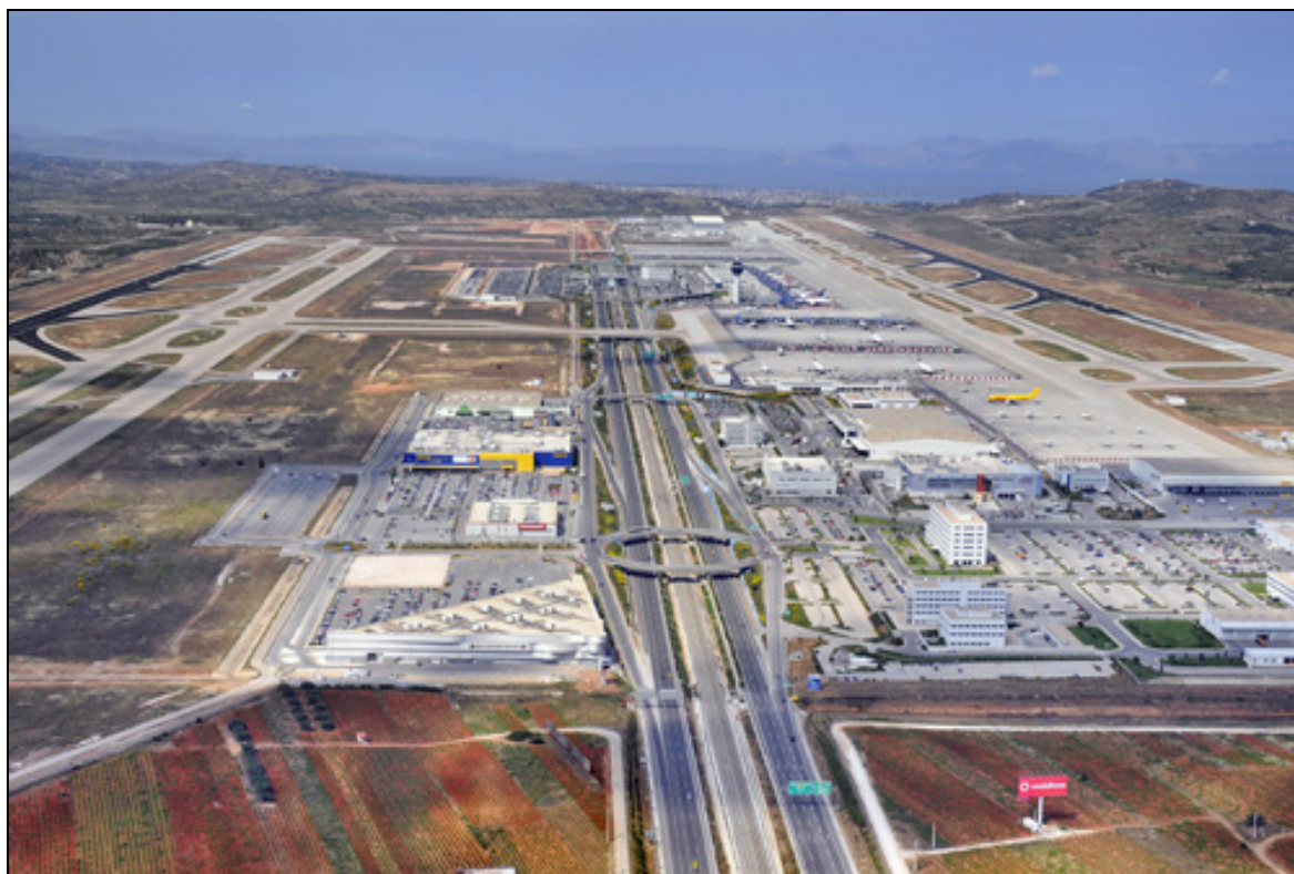
Σχήμα 5.2 Αεροφωτογραφία του ΔΑΑ [97]
