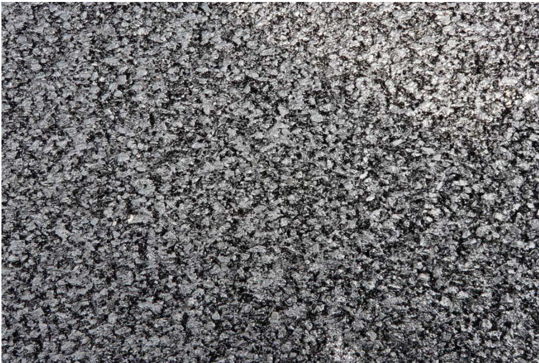
ασφαλτοτάπητας LOA 5 D μετά από κυλίνδρωση
