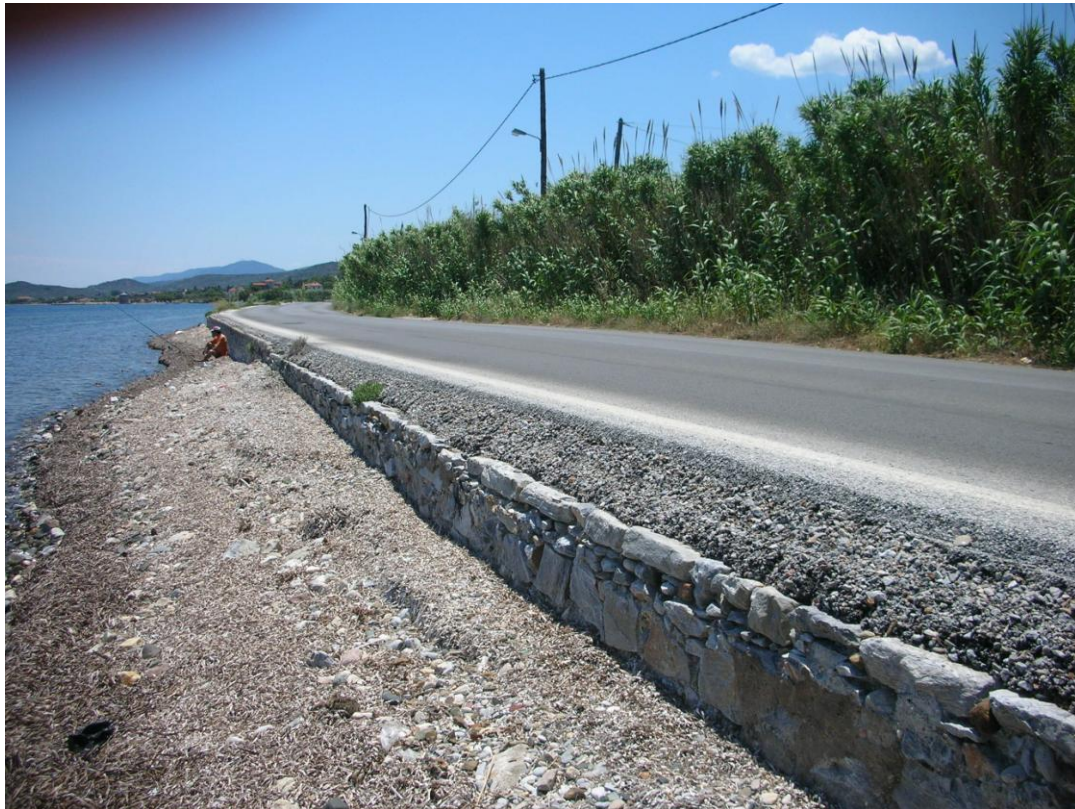
Σχήμα 2.1. Έργα αντιστήριξης παραλιακού δρόμου.
