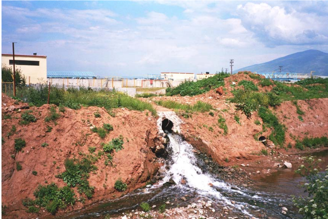
Φωτογραφία 1. Είσοδος των επεξεργασμένων λυμάτων από τον Βιολογικό Καθαρισμό Γιαννιτών στην Τάφρο Γιαννιτών.
