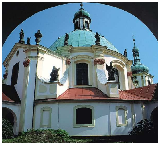
Obrázek 17: Měděnkou pokrytá střecha účinně brání další oxidaci
