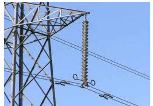
Obr. 11.16 Izolátor elektrického vedení pro VVN z tvrdého porcelánu
