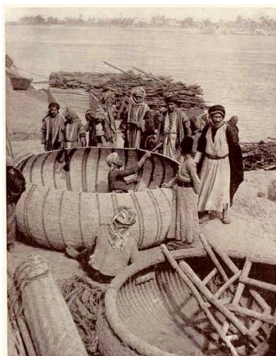
Fig.2. Costruzione di una quffa sul Tigri- 1914
