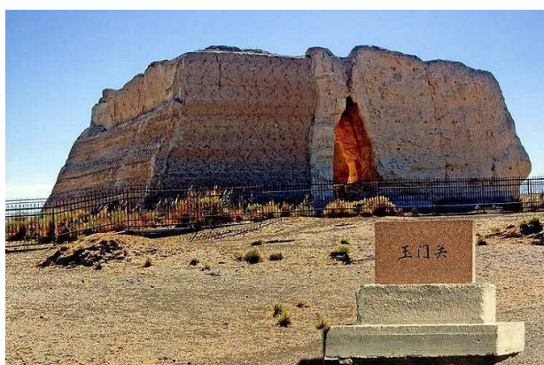
Nefrytowa Brama - kontrolny punkt na zachodniej granicy Chin
