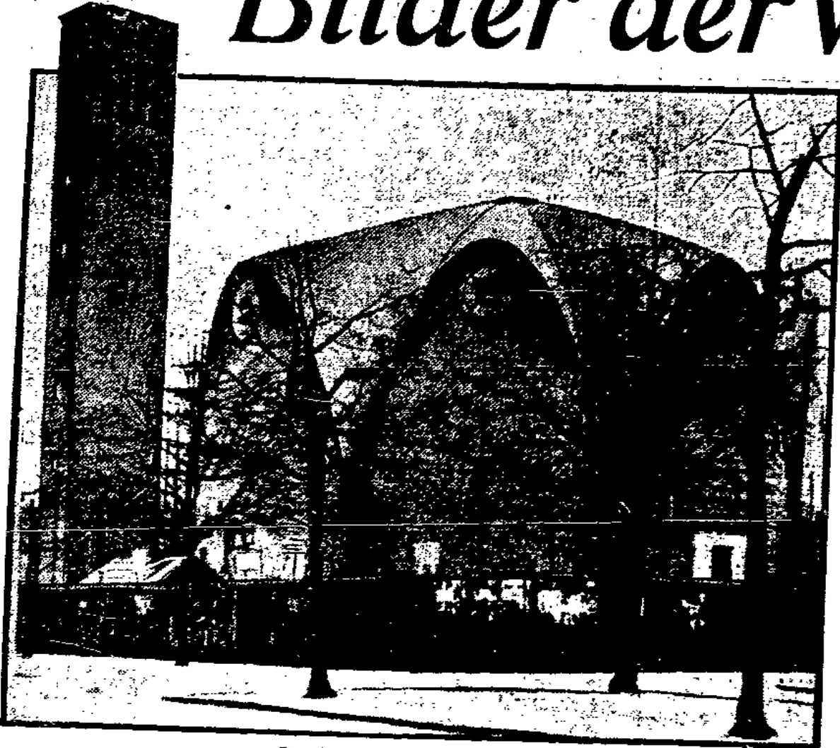
So baut man jetzt Kirchen Eine neue Kirche in Köln, die von Professor Böhm erbaut wurde. Sie glauben nicht, daß dieser Bau ungeteilten Beifall finden wird.
