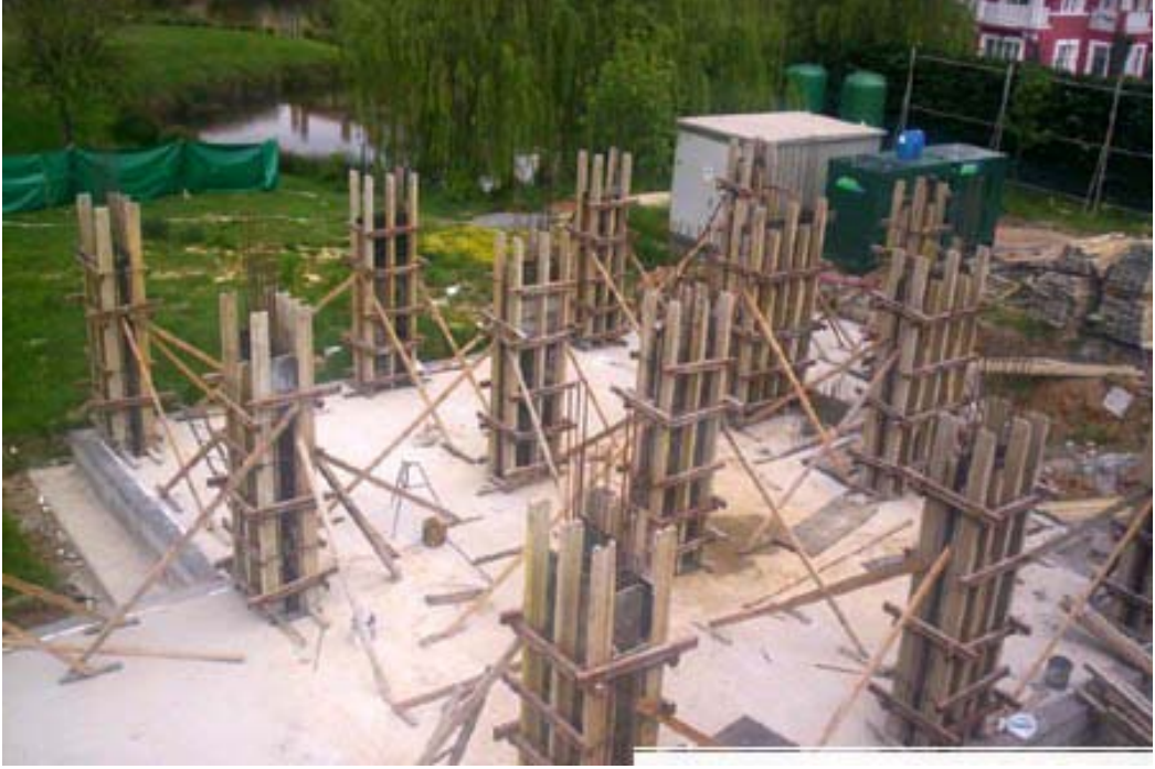
Resim 1.8: Bir kolon aplikasyonu uygulaması
