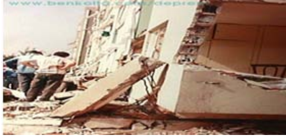
Resim 1.4: Eksik donatı kullanılan bir kolonun başına gelenler
