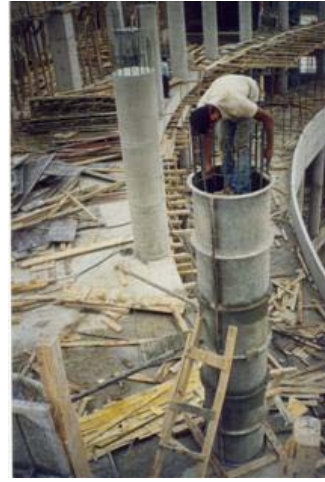
Resim 2.1: Etriyeli ve fretajlı (daire kesitli, fret demirli) kolonların inşa edilişi
