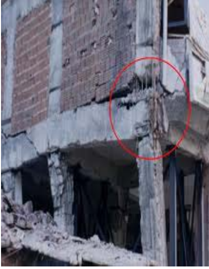
Resim 3.3: Hatalı kolon-kiriş birleşimi
