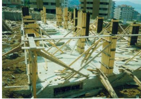
Resim 1.6: Kolonların çakılması
