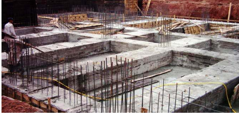
Resim 2.2: Temel inşası ve kolonların filizlerinin bırakılması
