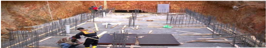
Resim.1.3: kolon yerlerinin temelde belirlenmesi
