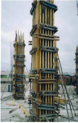
Resim 2.1: Etriyeli ve fretajlı (daire kesitli, fret demirli) kolonların inşa edilişi
