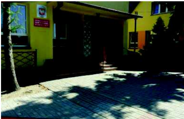
Fotografia 1. Budynek Przedszkola Samorządowego w Janowcu Wielkopolskim
