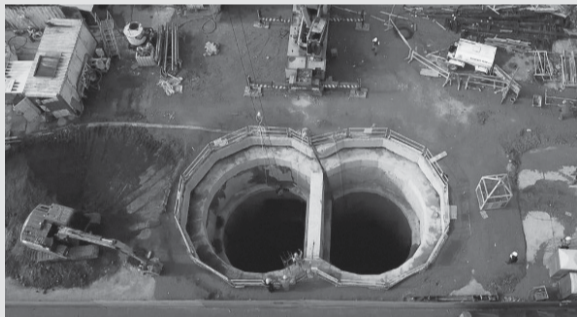
La estación elevadora que se construye en Temperley. En Esteban Echeverría habrá una de similares características.
