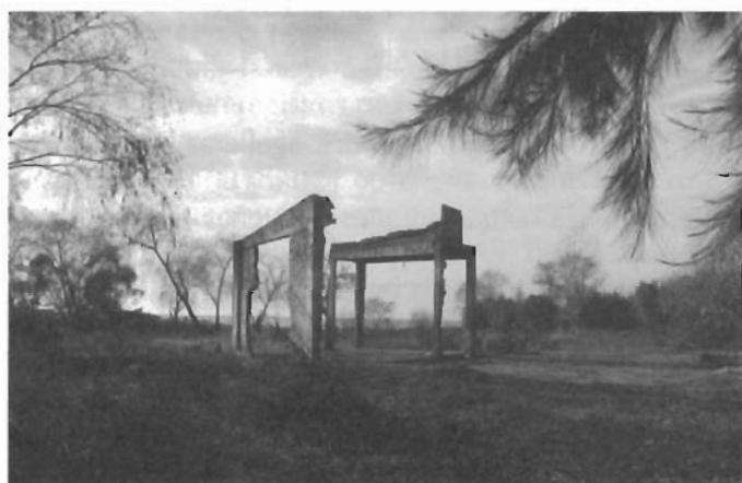
Figura 8. Ruinas de una antigua planta procesadora de pescado localizada en Playa Bagliardi, Berisso. Fotografía de C. Baigún, 2011.
