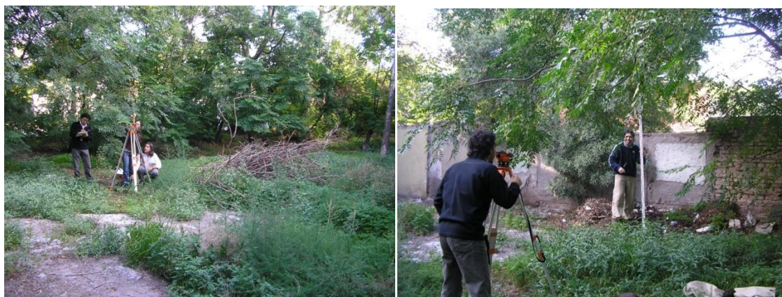
Figura 6.9. Vista general del PA La Caridad antes de comenzar los trabajos de excavación (instalación del nivel óptico).
