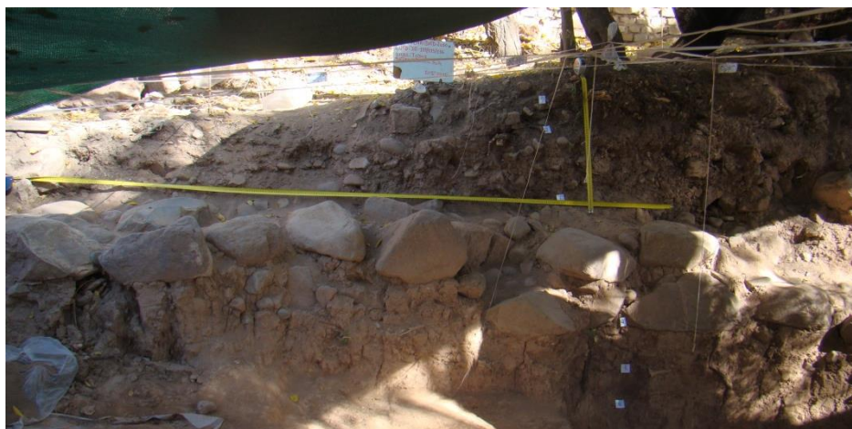
Figura 6.12. Alineación y apilamiento de piedras, posible cimiento de la pared sur del templo.
