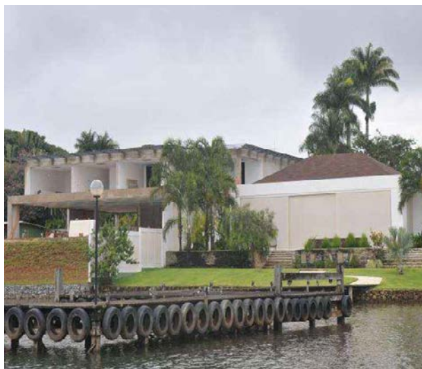
Figura 4. Casos comuns dentre as residências localizadas as margens do Lago Paranoá/DF é a implantação de acessos irregulares ao Lago.
