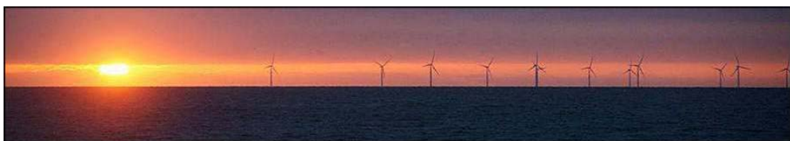
Υπεράκτιο αιολικό πάρκο στη Βόρεια Ουαλία
