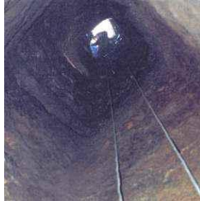
Εικόνα : Κατάβαση σ' ένα από τα πηγάδια καθαρισμού
