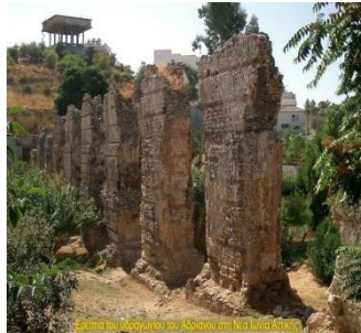
Εικόνα: Ερείπια του υδραγωγείου του Αδριανού στη Νέα Ιωνία
