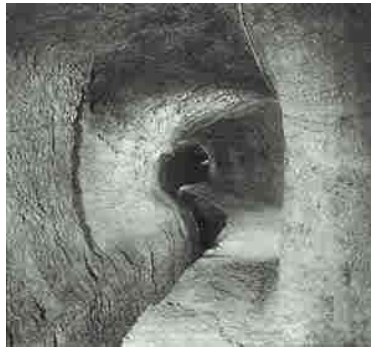
Εικόνα : Μέσα στο Ευπαλίνειο όρυγμα, διακρίνεται στο πλάι το αυλάκι για το νερό
