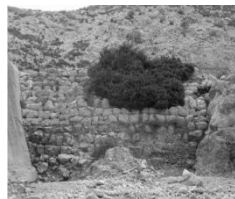
Εικόνα : Κατάντη παρειά του φράγματος (08/2004)
