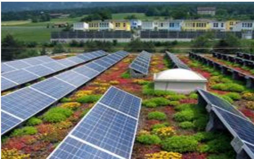
Εικόνα 12: Εκτατικός τύπος φυτεμένου δώματος
