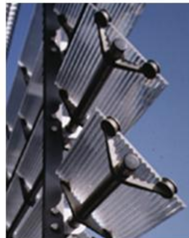
Εικόνα 18: Πρισματικά φωτοδιαπερατά υλικά. (Πηγή: Α. Μπάμπαλης, Μ. Παρασκευόπουλος, «Βιοκλιματικός ανασχεδιασμός κτιρίου κλειστού γυμναστηρίου πολυτεχνειούπολης Ζωγράφου», διπλωματική εργασία, ΕΜΠ, Αθήνα, Ιούλιος 2011, σελ. 25)
