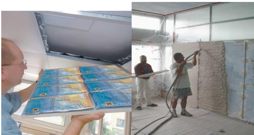
Εικόνα 35: Αριστερά Εφαρμογή PCM (Dorkens DELTA-COOL 24) σε σακουλάκια με αλουμινένιο περίβλημα, Δεξιά Εφαρμογή επιχρίσματος με πρόσμιξη μικροκάψουλων PCM. [Πηγή: http://www.econ3.gr (τελευταία επίσκεψη 5-09-2013)]
