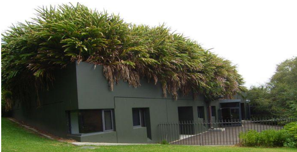
Εικόνα 11: Ημιεντατικός τύπος φυτεμένου δώματος
