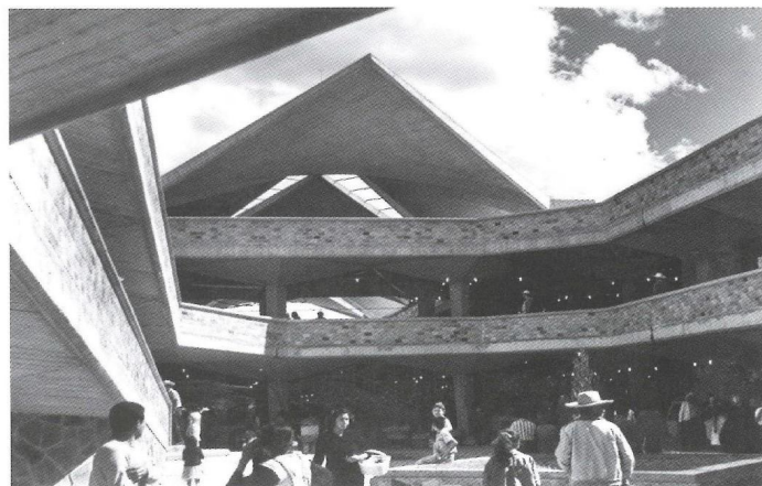
Portada: patio de la zona de comestibles en el Nuevo Mercado Libertad. Arquitecto Alejandro Zohn, 1959. Guadalajara, Jalisco. Archivo DACPAI.INBA.
