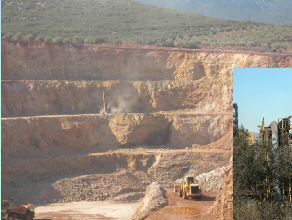
Λάρκο, περιοχή Λάρυμνας
