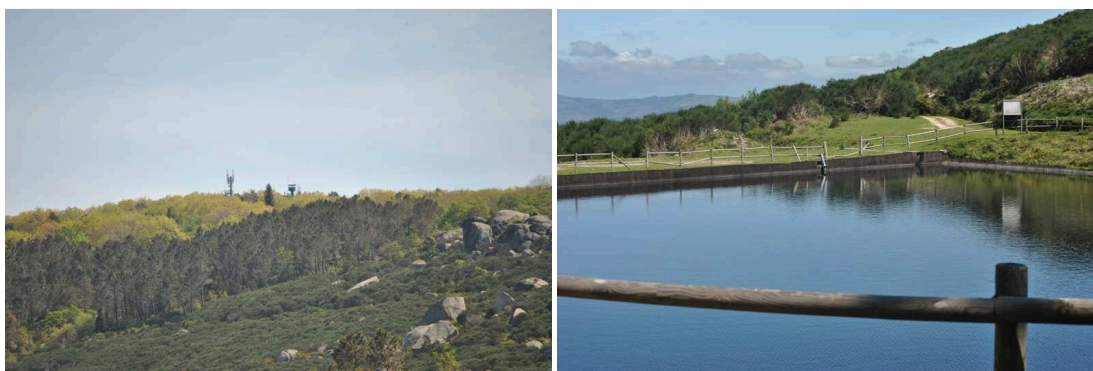
Figura 2.19. Infraestruturas de DFCI
