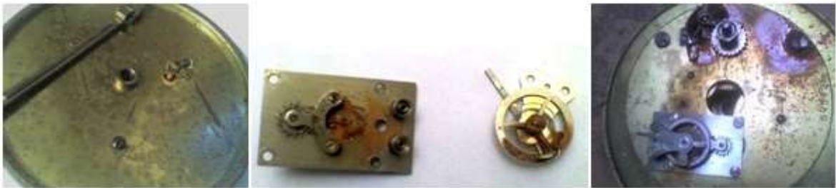
Figura 2.14 Óxido en partes del sistema de Relojería.
