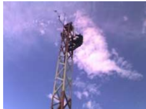
a. Instalación de Tuberías. b. Instalación del equipo de transmisión. Figura 4.11 Implementación del Pluviógrafo Electrónico.
