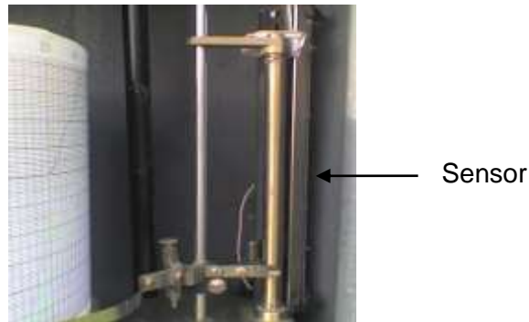
Figura 6.4 Instalación del sensor tipo potenciómetro deslizante.
