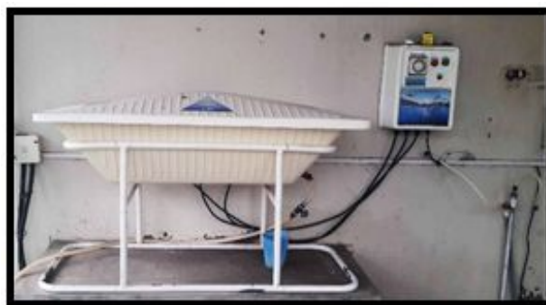
Figura 2. Equipo Ecológico productor de Hipoclorito de Sodio
