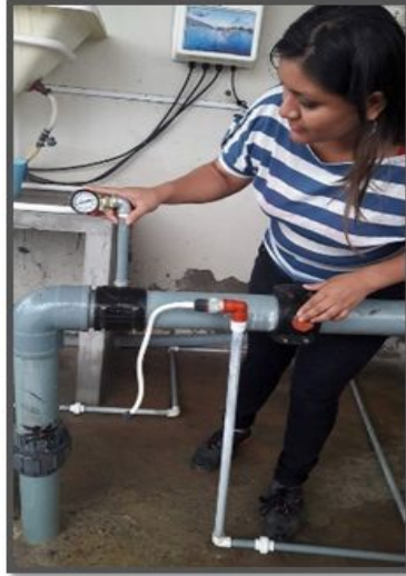
Figura 18. Medición de la presión con manómetro
