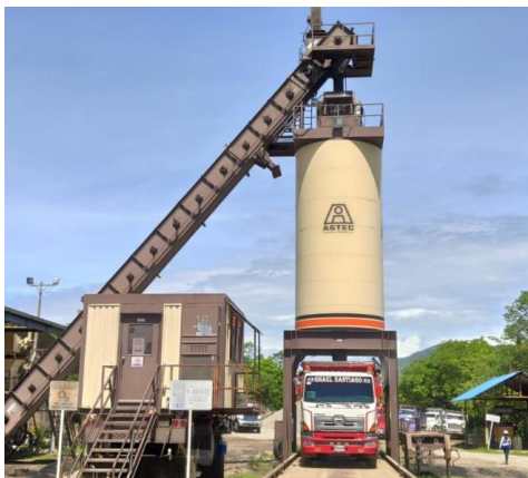
Figura 14. Transporte de mezcla asfáltica. (Lindarte, 2021)
