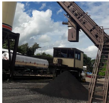
Figura 13. Rechazo de la producción de mezcla de asfalto (Lindarte, 2021)
