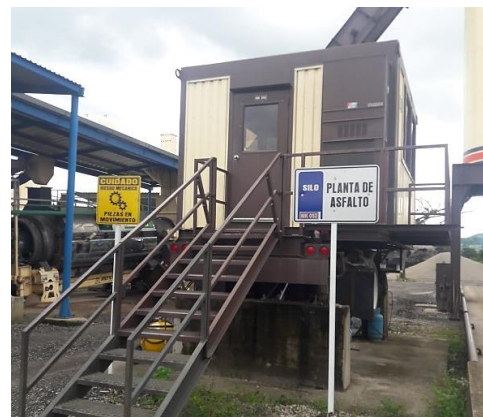
Figura 11. Centro de control de la planta de asfalto (Lindarte, 2021).
