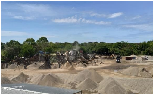
Figura 8. Acopio de material triturado (Lindarte, 2021).
