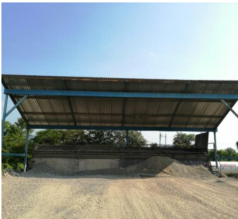
Figura 9. Tolvas de la planta de asfalto (Lindarte, 2021).
