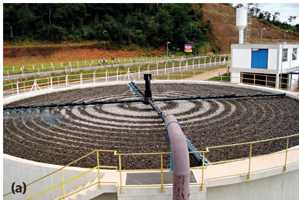
Figura 5 – a) Mala distribución del efluente en la parte superior del filtro biológico percolador post-reactores UASB; b) colmatación de lecho de piedras por elevación de la carga de sólidos.
