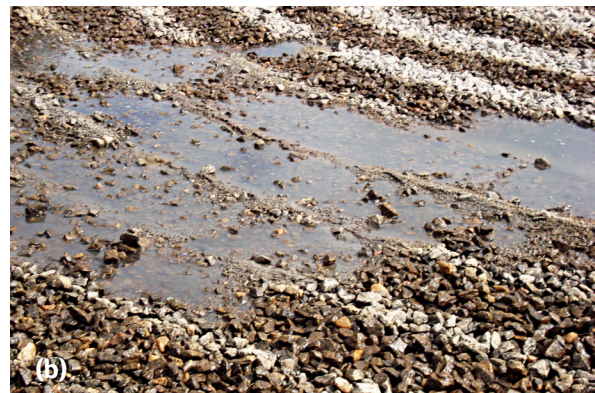
Figura 5 – a) Mala distribución del efluente en la parte superior del filtro biológico percolador post-reactores UASB; b) colmatación de lecho de piedras por elevación de la carga de sólidos.
