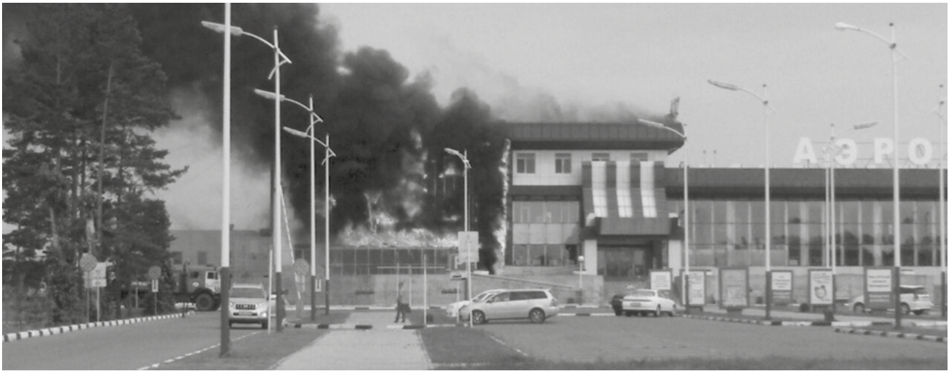
Рисунок 1 – Пожар в здании аэропорта г. Благовещенска [7]
