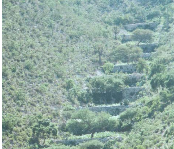
Imagen 10.9.1. Presa retenedora de azolves
