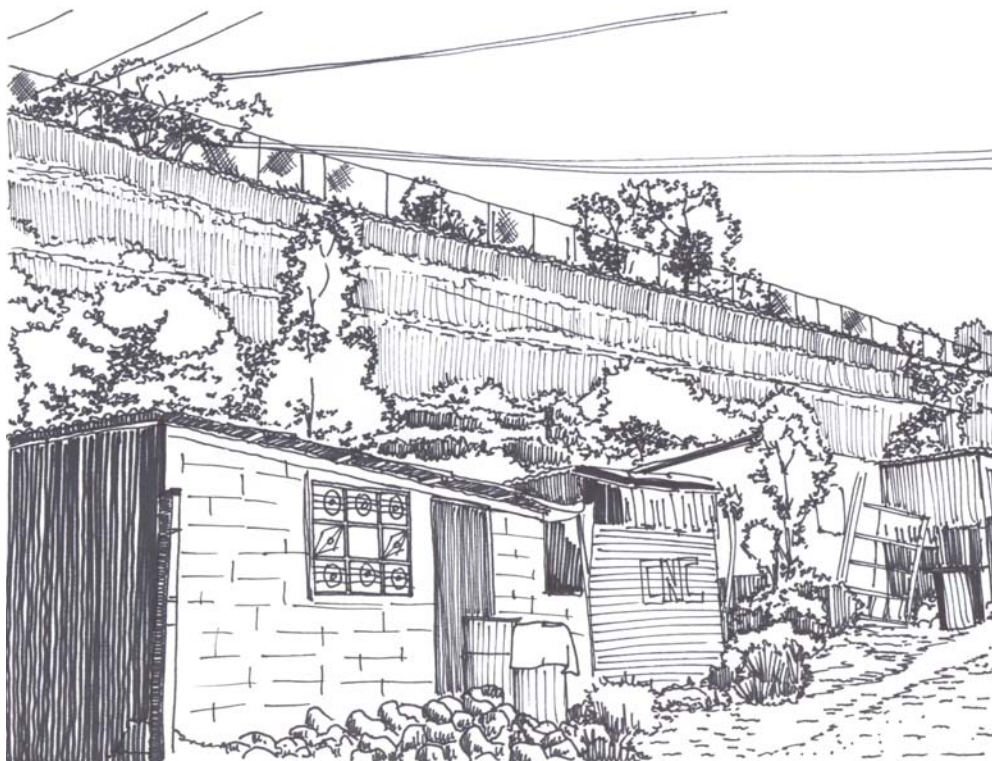
Imagen 9.6.1.A. Estado actual de talud
