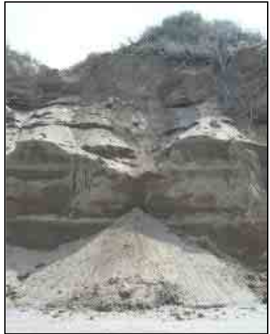
Foto 19 Combinación del efecto del oleaje de tormenta, saturación por humedad y sismo en el talud costero
