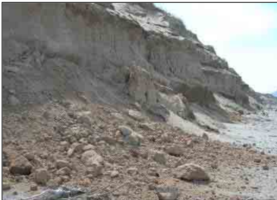
Foto 20 Combinación del efecto del oleaje de tormenta, saturación por humedad y sismo en el talud costero Predio Pozo de Rodríguez
