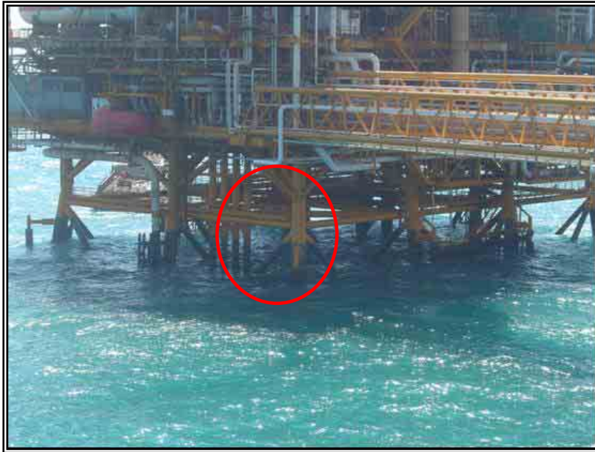
Fotografía VIII. 5. Pierna donde se conectará el ducto ascendente del oleogasoducto submarino de la Plataforma de Perforación Abkatun-B.
