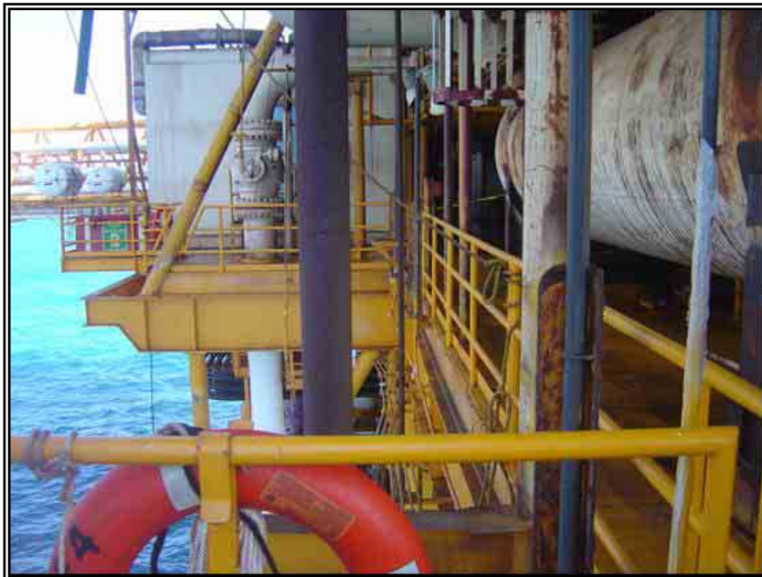
Fotografía VIII. 6. Vista Lateral del Espacio donde construirán el Cantiliver para la Trampa de Diablos de la plataforma Abkatun-A Permanente.
