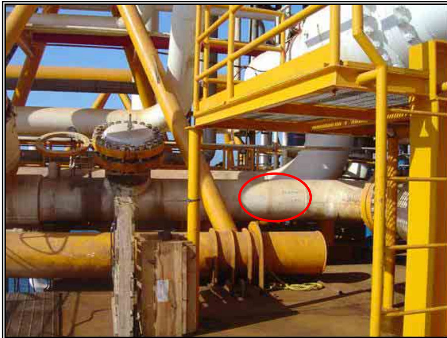
Fotografía VIII. 8. Interconexión con el ducto submarino de 24" de diámetro.
