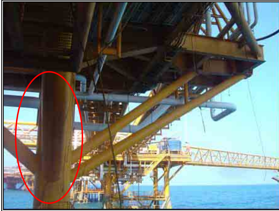
Fotografía VIII. 7. Parte alta de la pierna de llegada del ducto ascendente de Abkatun-B.
