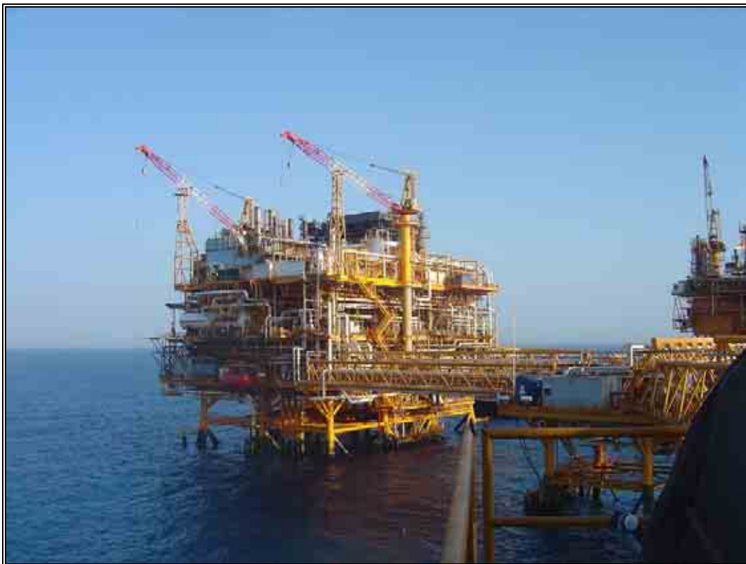
Fotografía IV. 1. Plataforma Permanente del Centro de Proceso Abkatun-A.
