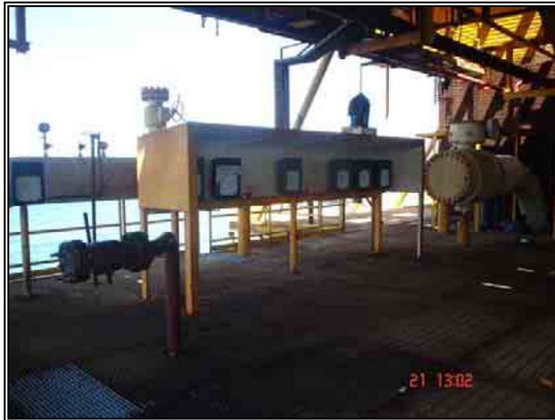
Fotografía VIII. 1. Salida hacia la plataforma permanente de Abkatun-A.
