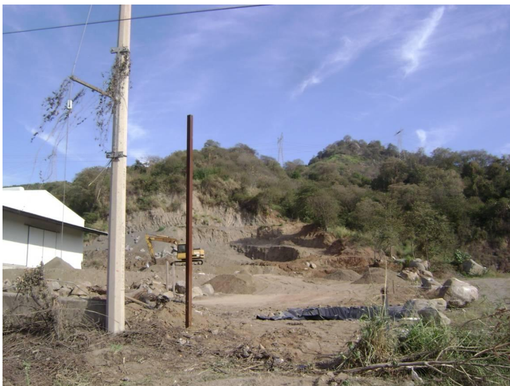
Foto 22. Extracción de material pétreo en la cercanía del proyecto. La imagen hace referencia a la parte media del trazo proyectado para la obra.
