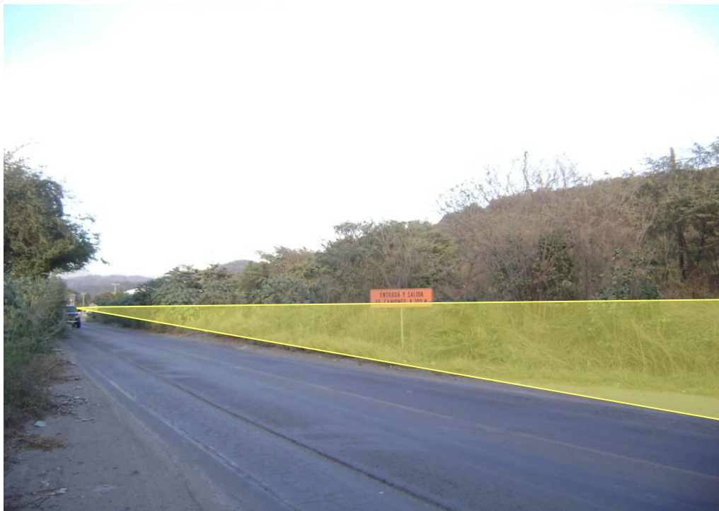
Foto 15. Acceso al Patio Fiscalizador. Actualmente en esta zona se presentan problemas de seguridad vial en el transporte particular local. La flecha indica el acceso al Patio.
