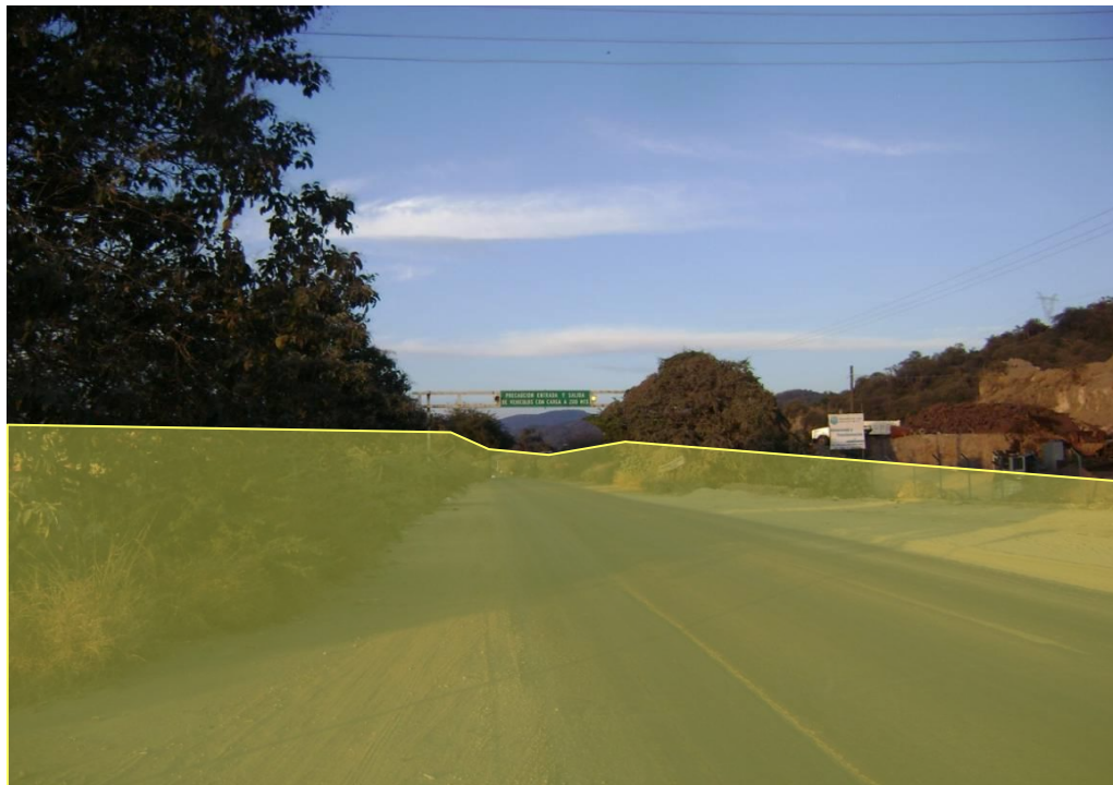
Foto 19. Vista general del sitio donde inicia la obra
