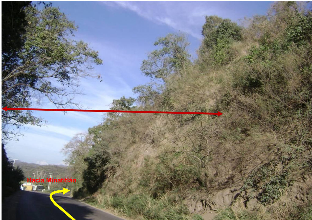
Foto 7. La línea Roja indica el área donde se efectuará la ampliación de la infraestructura. El espacio corresponde al área de SBC.
