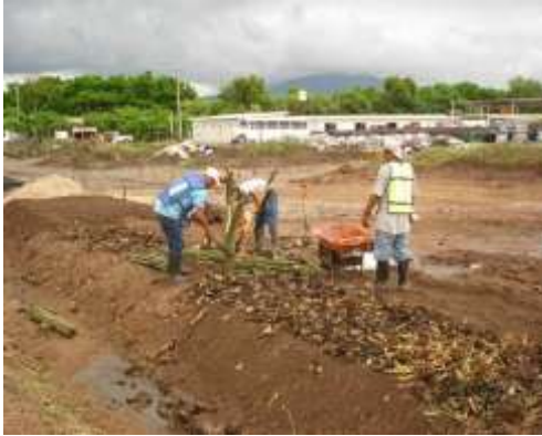
Pilas de suelo rescatado y colocación de material vegetal triturado producto del desmonte
