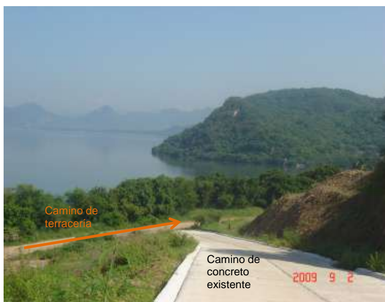
Foto II.1.- Vista del camino de terracería (naranja) y el camino de concreto existente al que dará continuidad el camino sujeto al presente estudio.
