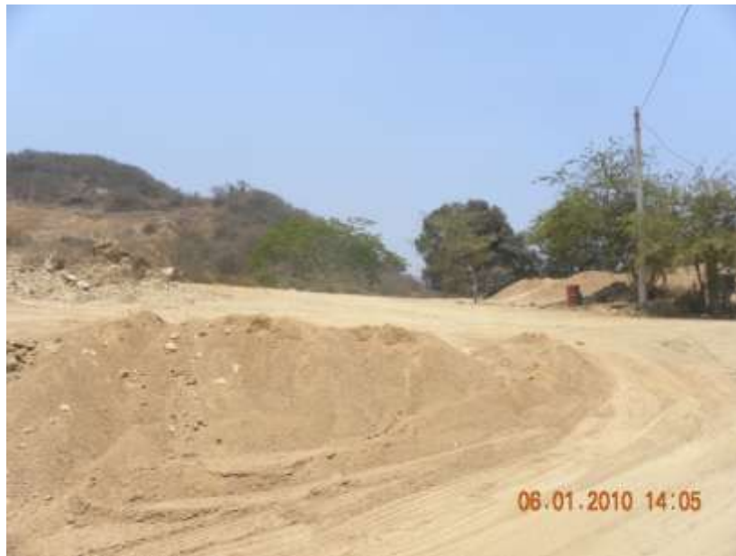
Fig. II.7. Camino de terracería por el cual pasará el camino llamado “Camino El Edén”
