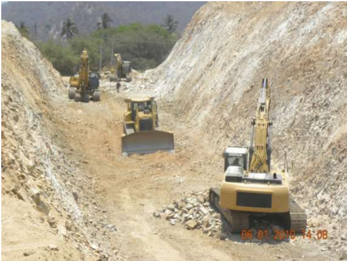
Figura VII.10. Actividades de Construcción del Ramal Ferroviario, adyacentes al predio del Proyecto "Camino El edén".
