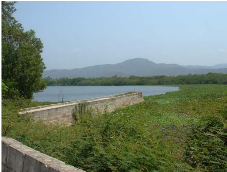
Figura IV.8. Aspecto del sitio en el que se desarrollará el proyecto, con manglares al fondo y mantos de lirio acuático.
