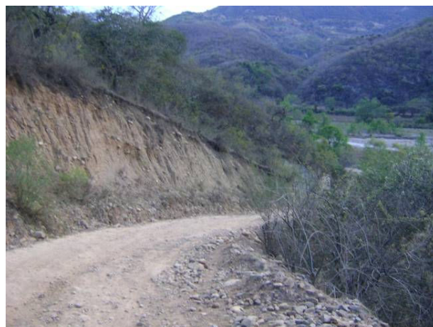
Figura 9.- Zona de proyecto. Puente Vehicular Cuyuxtlahuaca
