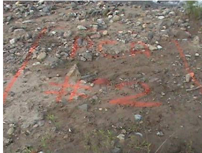
Figura 43 Ubicación de Pozo a cielo abierto 2, Puente Vehicular Cuyuxtlaahuaca
