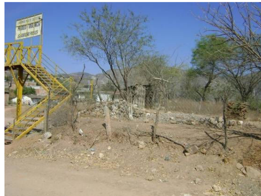
Vista de muro de gaviones cercano al río
