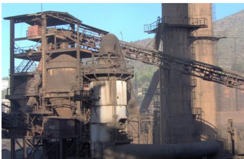
Σχήμα 2.10: Σύστημα αποκονίωσης εργοστασίου Λάρυμνας
