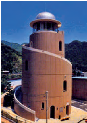
Abri d'urgence qui sert aussi de centre social et de musée pour la prévention des catastrophes. Kisei, préfecture de Mie, au Japon. Le bâtiment a 22 mètres de haut et 5 niveaux, pour une surface totale de 320 m 2 . Il peut accueillir 500 personnes. Crédit documentaire : http://www.pref.mie.lg.jp/ENGLISH/
