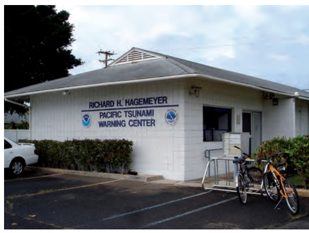
Installations du PTWC à Ewa Beach, Hawaii, États-Unis
