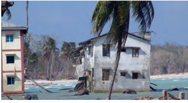
Le séisme du 26 décembre 2004 s'est traduit par une subsidence terrestre de 1,2 m à Car Nicobar, dans les îles Nicobar, en Inde. Des maisons, jadis au-dessus du niveau de la mer, baignent à présent dans l'eau. Crédit photographique : ICMAM, Chennai, DOD, Inde
