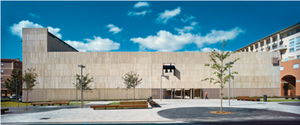
3.1 Imagen exterior del conjunto Templo y Centro Parroquial San Jorge Pamplona, Navarra, España. http://www.pedropegnaute.es/index.php?ongoing/iglesia-de-san-jorge/
