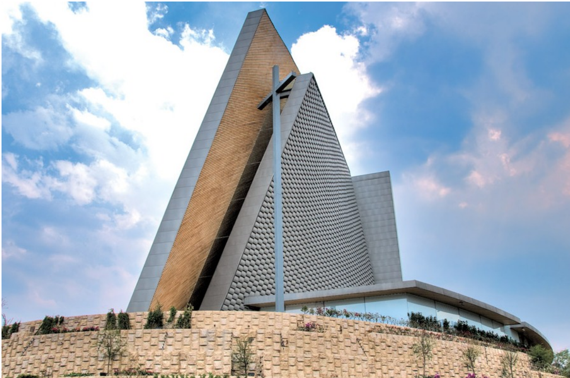
1.1 Imagen exterior del centro comunitario José María Escrivá, Santa fe México D.F. http://iglesiadesantafe.org.mx/ 11/02/2011
