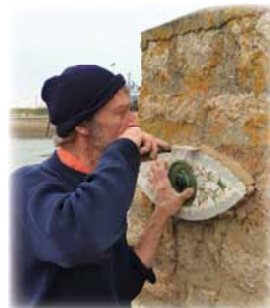
> L'œil en cours d'installation par Pierre CHANTEAU
