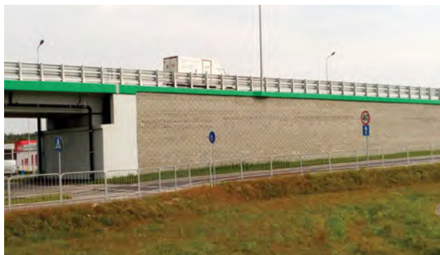
Rys. 2. Nasyp na dojeździe do wiaduktu w ciągu drogi DK9 k/Rzeszowa
