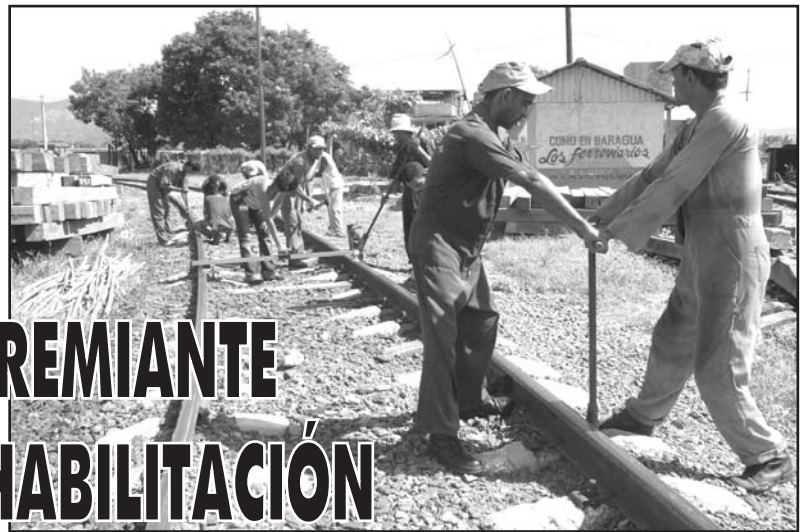
Brigada de vías en plena faena
