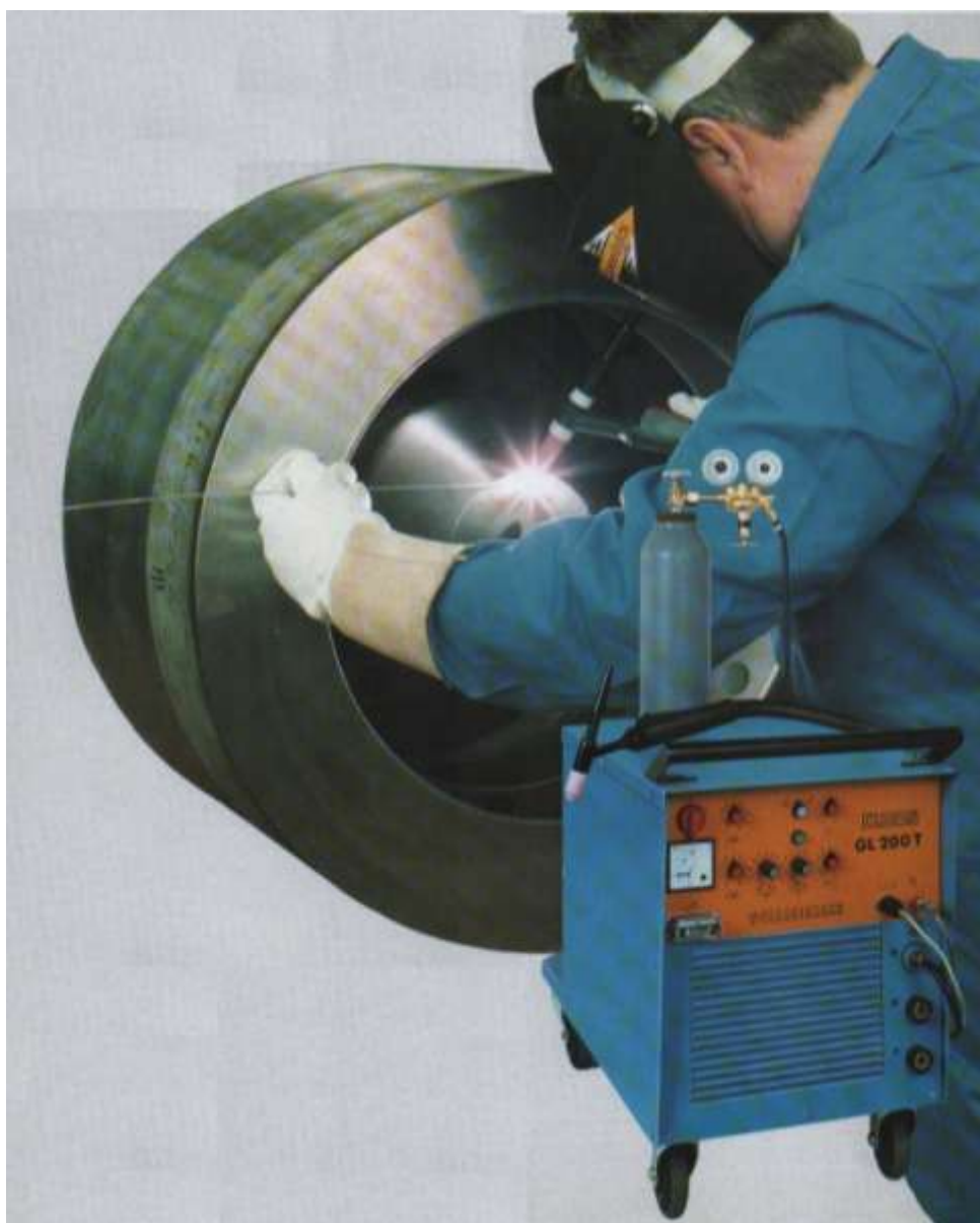
Obr. 98 Svařování nerezavějící oceli metodou WIG svařovacím zařízením GL 200 T firmy CLOOS
