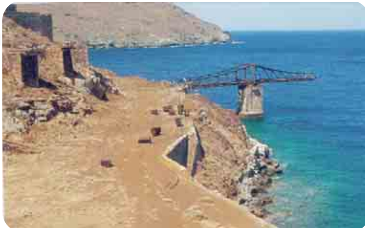
ΕΙΚ. 8: Σέριφος (Μεγάλο Λιβάδι): Μεταλλείο σιδήρου που έκλεισε οριστικά το 1964.
