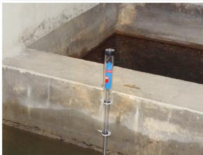
Fig. 4.8: Sensore di livello idrico e datalogger installato nella vasca di laminazione del partitore, a monte dello stramazzo.
