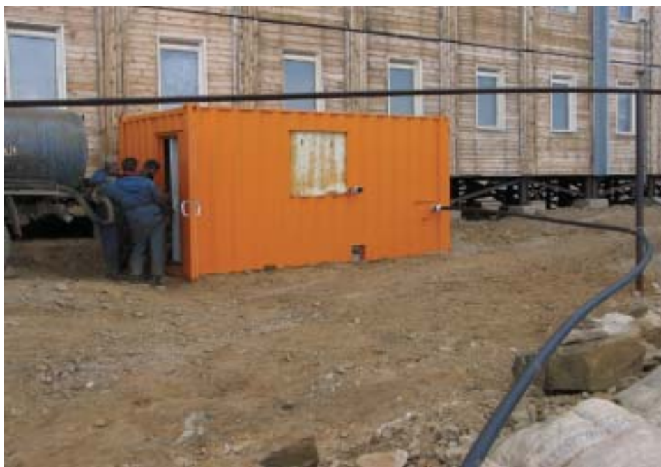
Рис. 4.2. Станция Прогресс. Контейнерный модуль комплекса очистки сточных вод СЖК «Лена»
