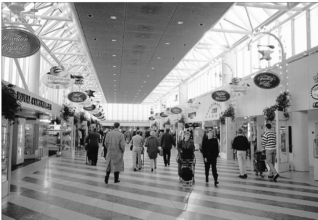
Figura 1.1: sistema combinato d'illuminazione naturale e artificiale in un edificio pubblico (aeroporto internazionale di Copenaghen, Danimarca)
