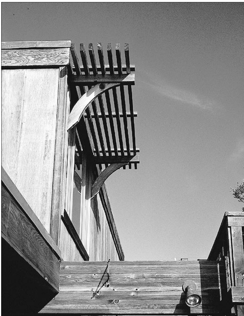
Figura 3.20: elemento fisso di protezione contro il sole sulla facciata a sud (ripresa fotogra- fica eseguita in inverno: l'irradiazione so- lare non viene bloccata)
