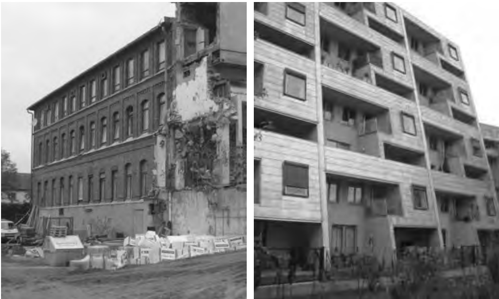
Σχ. 2.12. Άποψη του παλιού εργοστασίου και των κτιρίων του νέου συγκροτήματος.
