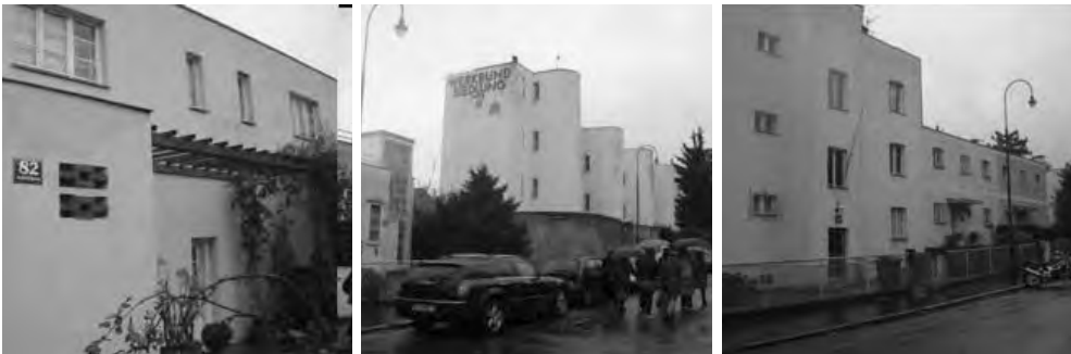
Σχ. 2.7. Απόψεις της γειτονιάς Werkbundsiedlung.
