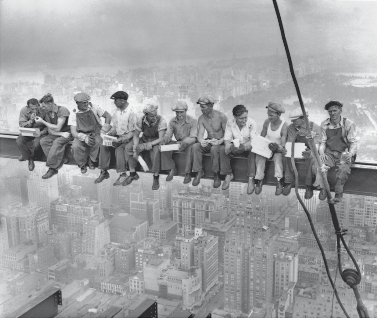
Trabajadores de la construcción de Nueva York almorzando sobre una viga, Charles Clyde Ebbets, 1932. © Bettmann/CORBIS
