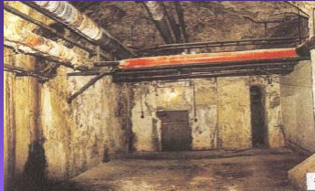
Su ve rutubet almış bir yapı Anti Nem Sıva Uygulanmış bir yapı
