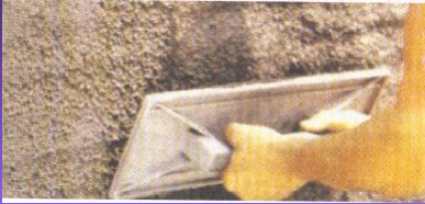
Yüze Sıva Küreği ile Uygulama
