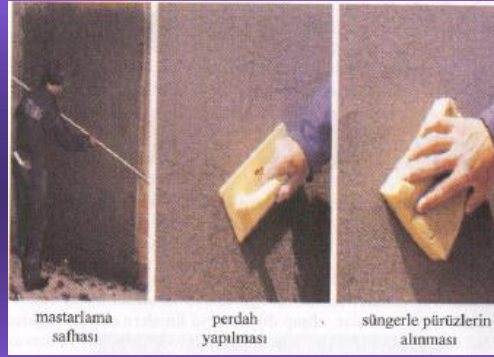
Anolar Arasının Sıva ile Doldurulup Mastarlanması
