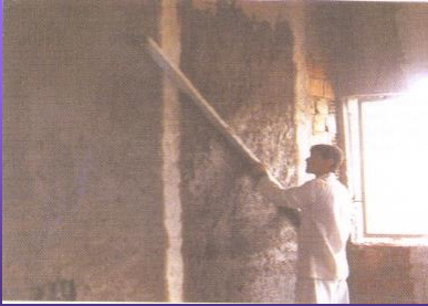
Anolar Arasının Sıva ile Doldurulup Mastarlanması
