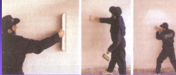
Alçı Sıva Yüzeyi Parlatılması
