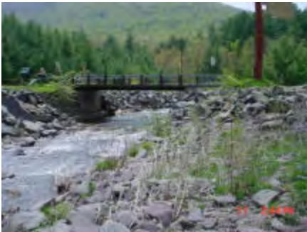
Aufarth Road Bridge
