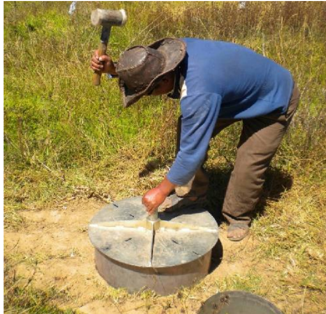
Foto 3. Hincado de las anillas
